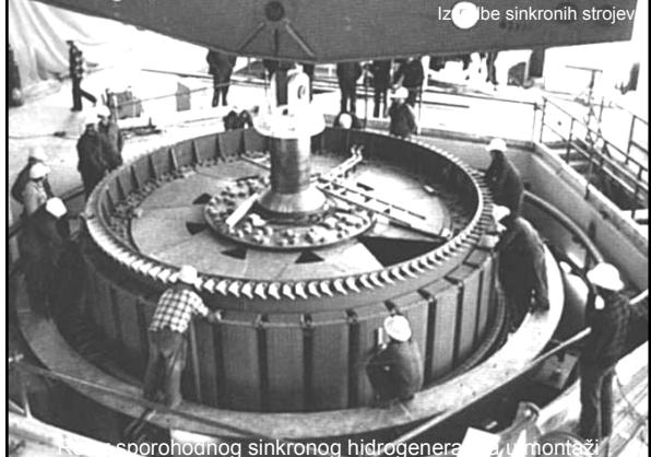
Sporohodnog sinkronog hidrogeneratora u montaži
