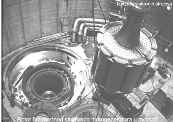
Rotor brzohodnog sinkronog hidrogeneratora u montaži
